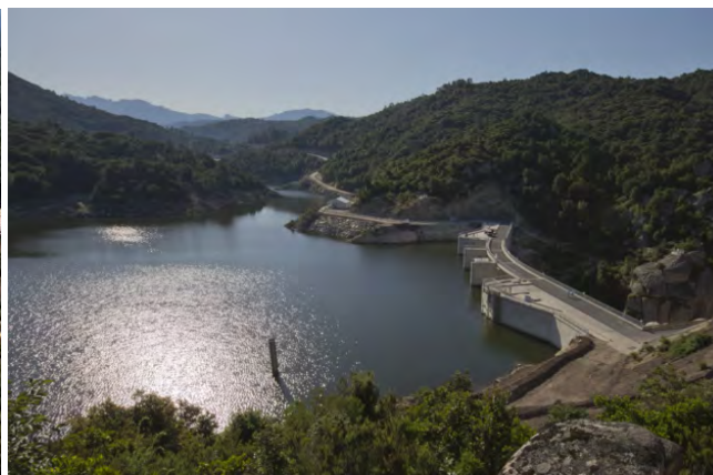
Illustration 97 : Barrage de Rizzanese (Source : Collectivité de Corse)
