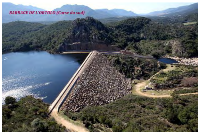
Illustration 96 : Barrage de l'Ortolo (Source : Comité Français des Barrages et Réservoirs - CFBR)
