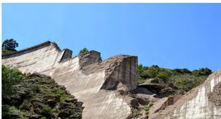
Illustration 95 : Ruines du barrage de Malpasset dans le Var (Source : futura-sciences.com)
