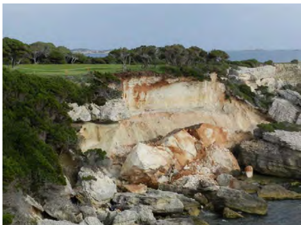
Illustration 53 : Effondrement sur le littoral de Sperone (Bonifacio), 2014 (Source : Corse Matin)
