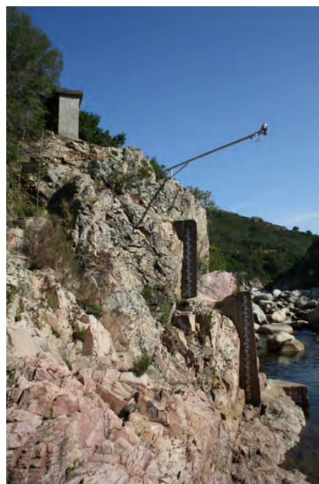
Illustration 48 : Échelle limnimétrique et sa cellule automatique à la station de Peri. Source : DDTM 2A, 2019.
